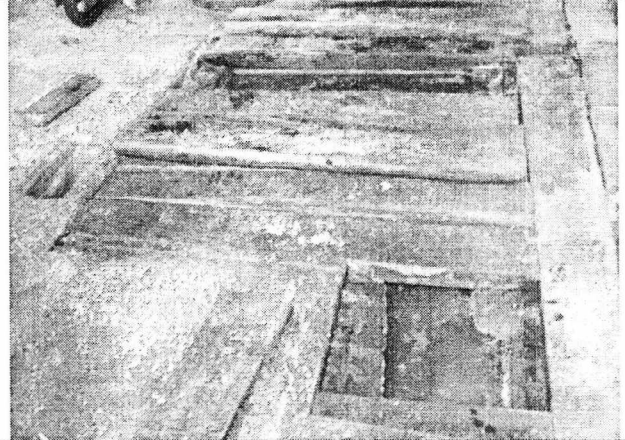
Foto 14. Cárcamo y tanque sedimentador saturados de ARND.
