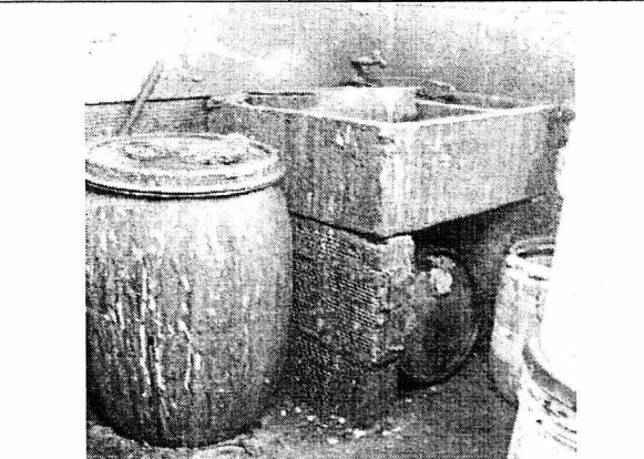
Foto 26. Zona de generación de ARND pintadero, 3er piso.
